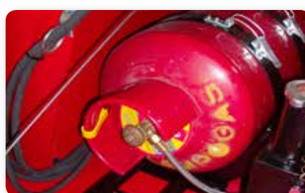
Impianto GPL LPG system Instalación de GLP
